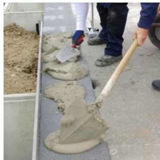
Unebenheiten der Bodenplatte werden mittels Mörtelausgleichsschicht (=Kimmerschicht) korrigiert. Sie sollte im Regelfall 30 mm nicht überschreiten.
