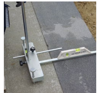
Der Anlegefix garantiert schnelles und maßgenaues Anlegen der Mörtelausgleichsschicht auf Keller- und Geschoßdecke.
