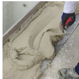
Dazu wird zuerst mit der Schaufel großzügig Kimmerschichtmörtel aufgebracht und mit der Kelle verteilt.
