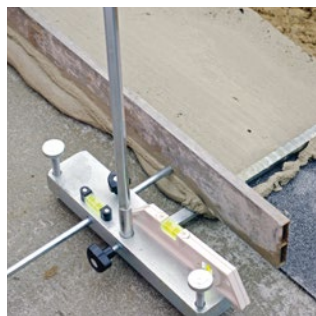
Es entsteht eine ebene Unterlage für die erste Ziegellage – Grundlage für das exakte Hochziehen der Wand.
