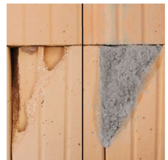
Kimmerschicht erstellen, Fehlstellen und Stoßfugen vermörteln – alles mit dem selben Mörtel möglich!
