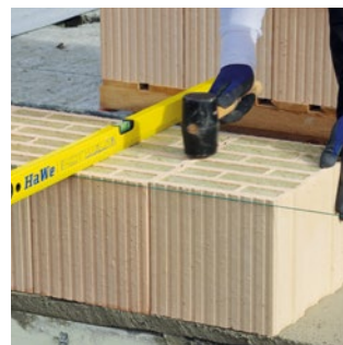
Die erste Ziegellage wird auf das exakt abgezogene Mörtelband gesetzt. Mit Wasserwaage und Gummihammer werden die Ziegel feinjustiert.
