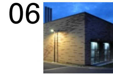
06 Energiezentrale Hochschule Aschaffenburg
