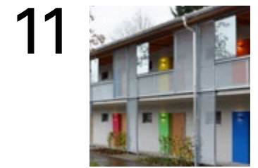
11 Wohnanlage Herzogsägmühle Peiting
