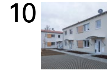
10 Staatliche Wohnanlage Straubing
