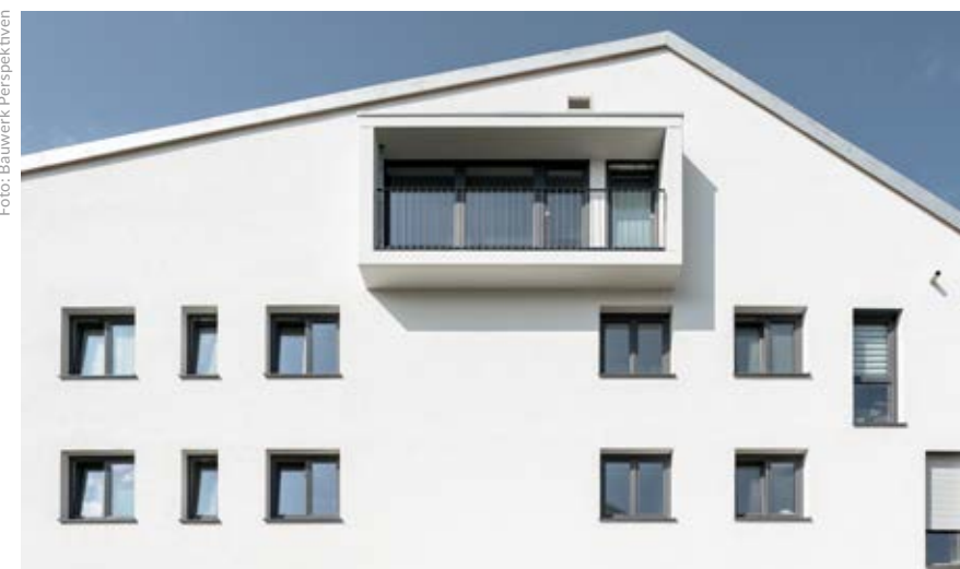
Wie ein Guckkasten ragt der Balkon des Dachgeschosses aus der Fassade. Die versetzte Anordnung der bodentiefen Fenster »stört« die Linienführung der Fenster.
