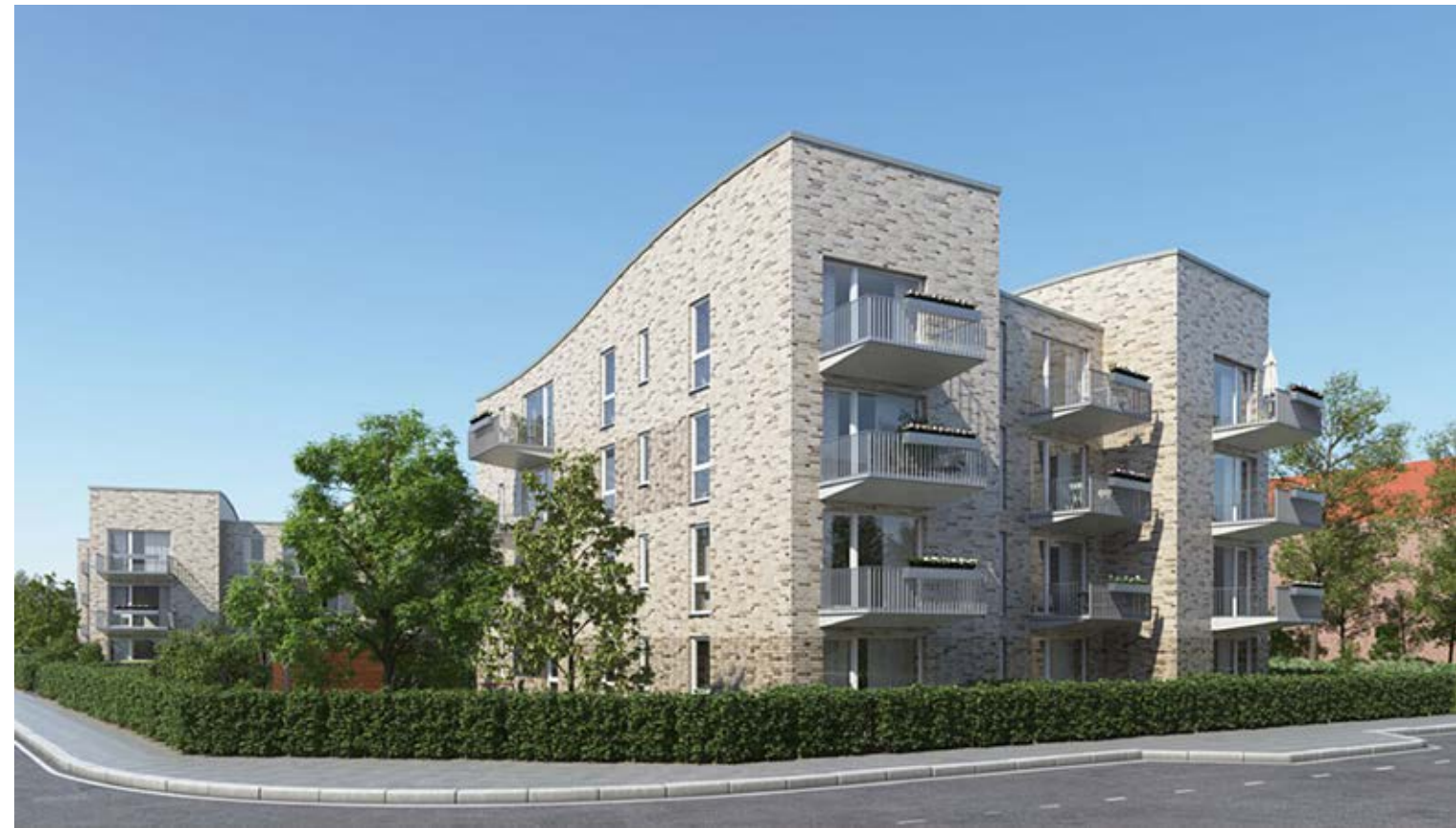
Wellenförmig angelegte Flachdächer, eine versetzte Anordnung und Verblendsteine in einem warmen beige-braunen Farbton werten den Stadtteil optisch auf.
