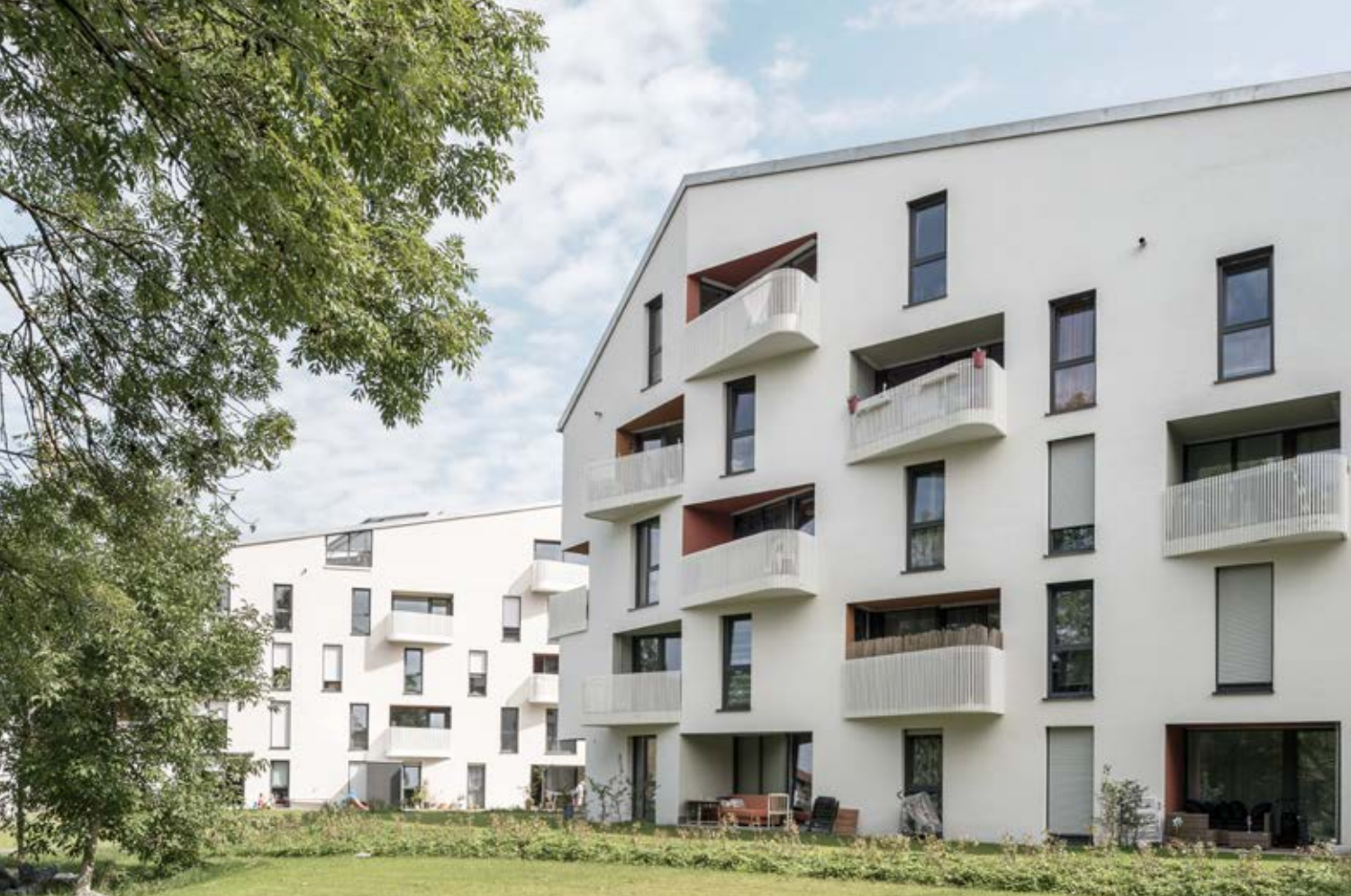
Foto: Bauwerk Perspektiven
