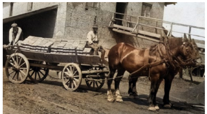
Der Großvater der heutigen Geschäftsführer lieferte die Ziegel noch mit dem Pferdegespann aus.
