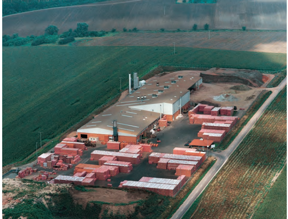
Bild 29 Gesamtansicht eines modernen Ziegelwerks.
