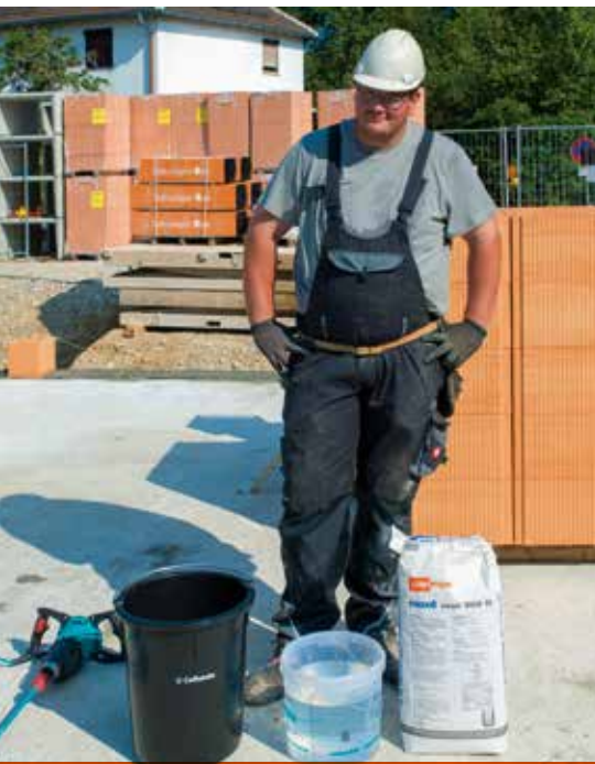
Werkzeug und Mörtel vorbereiten
