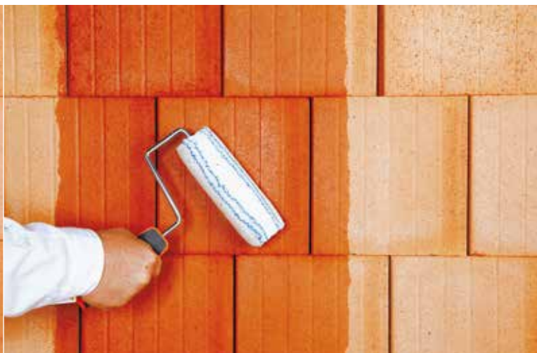
Grundieren des Mauerwerks 02
