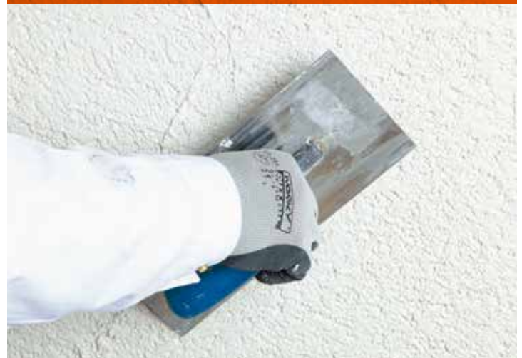
Strukturieren des Oberputzes mit der Glättkelle
