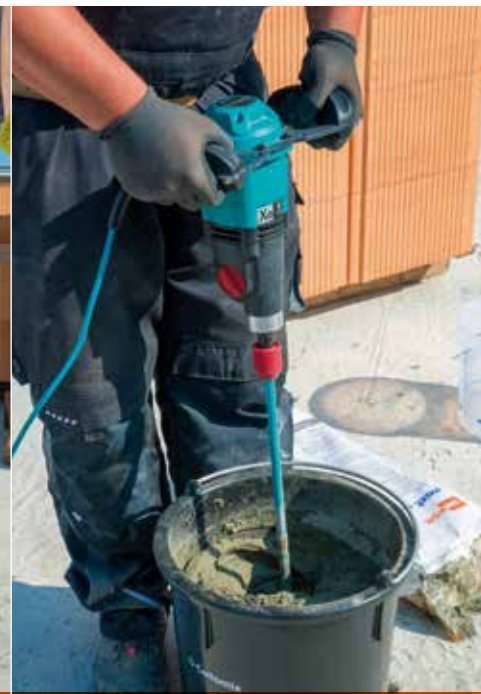
Anmischen des Dünnbettmörtels
