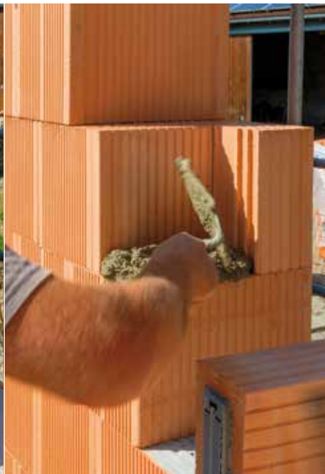
Einpassen des Formteils
