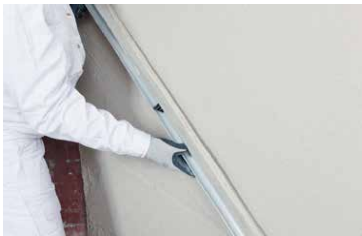
Egalisieren mit der Abziehleiste 05
