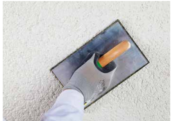
Verputzen von Mauerwerk schützt und sieht gut aus
