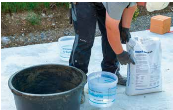
Dünnbettmörtel und Eimer
