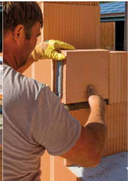
Setzen des Gurtwicklers
