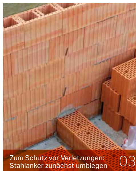
Einlegen der Flachstahlanker in den Dünnbettmörtel 01
