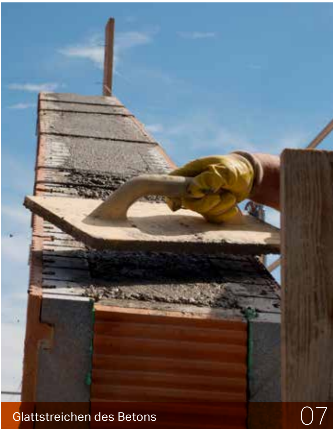
Ergebnis: Ringanker als optimierte Wärmebrücke
