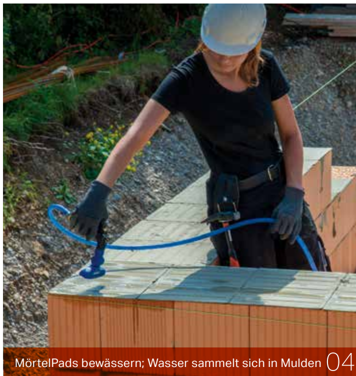
Ziegel direkt auf das durchfeuchtete MörtelPad
