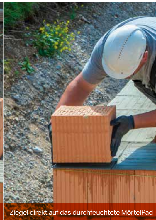
MörtelPads bewässern; Wasser sammelt sich in Mulden
