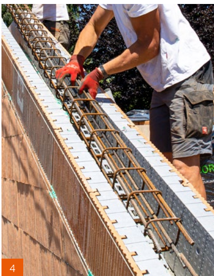
4 Nach Dem Aushärten: Montagebügel ab- nehmen und Bewehrung einlegen
