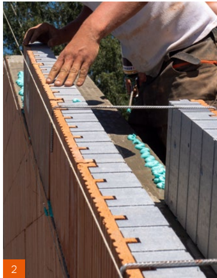
2 DSR setzen und mit Montagebügel sichern
