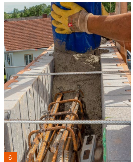
6 Beton verfüllen und verdichten, anschließend glatt streichen.
