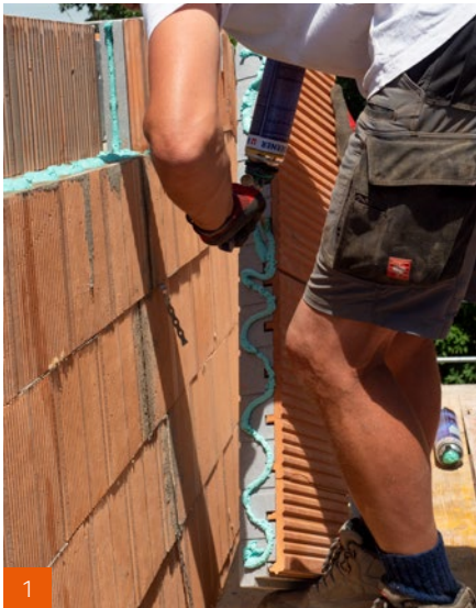
1 Dünnbettmörtel / alternativ Montage- schaum auftragen
