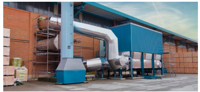
Die Rauchgasnachverbrennungsanlage im Werk 2 Dachau.
