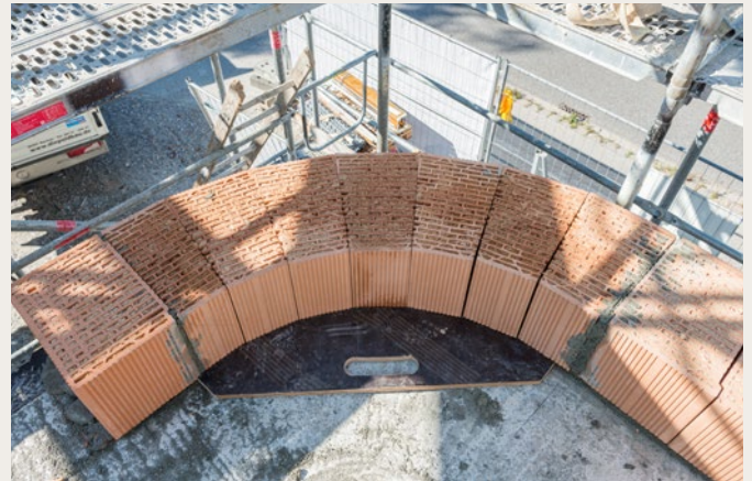
Die Schaablonen sind jeweils so konzipiert, dass Sie vom Verarbeiter an der inneren Wandseite mit einem Handgriff problemlos angesetzt werden können.
