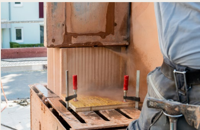
Auf der Baustelle werden die Außenwandziegel präzise geschnitten. Die jeweiligen Schnittwinkel sind im Ausführungsplan exakt vorgegeben.
