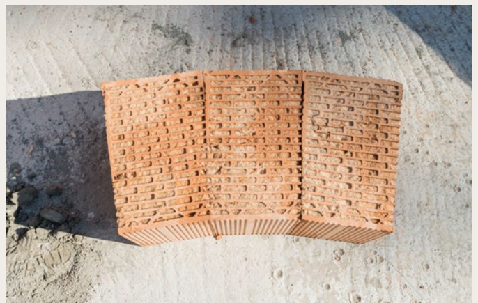
Die nach Winkelschablone unterschiedlich geschnittenen Ziegel fügen sich ohne Spalt aneinander und bilden so den gewünschten Radius der zu mauernden Wand.
