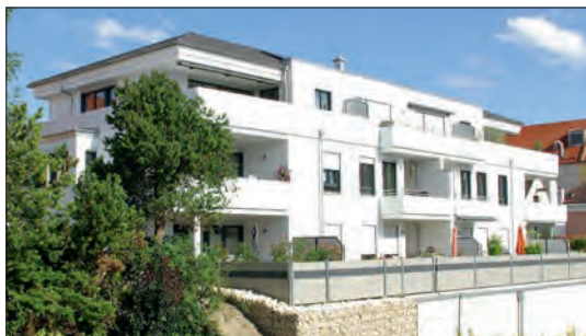
32) Wohnanlage (mit MZ10 gebaut)
