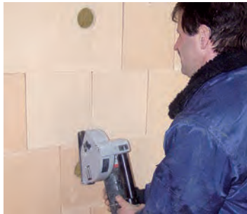
Schlitzten der Ziegel mit der Schlitzfräse.
