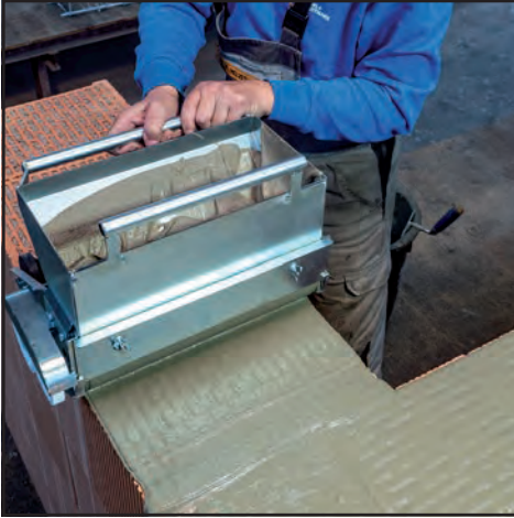
Auf der obersten Ziegellage wird eine deckelnde Mörtellage aufgebracht.
