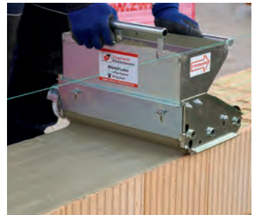
Mit der VD-Mörtelwalze wird der Mörtel rationell und einfach aufgetragen. Die Mörtelrolle "deckelt" in einem Arbeitsgang die Lagerfuge. Die Ziegel können nun gesetzt werden.
