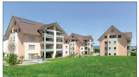
33) Wohnanlage nahe des Züricher Flughafens (mit MZ10 gebaut)
