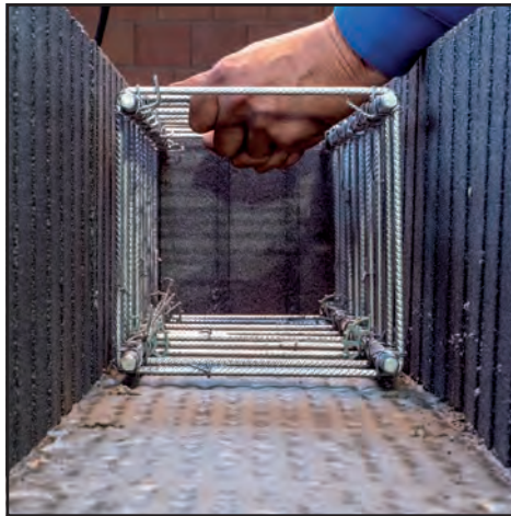
Im Zwischenraum ist 30 % mehr Platz für starke Bewehrung als bei konventioneller Bauweise.
