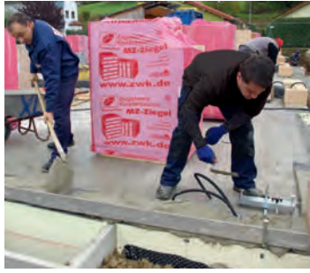
Auf der Betondecke wird zunächst eine Bitumenpappe R500 ausgelegt, Stöße 20 cm überlappend. Um Unebenheiten im Untergrund auszugleichen, wird eine Ausgleichs-
