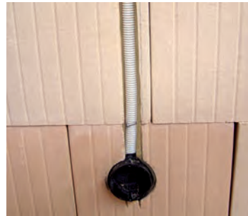
Einlegen der Elektroinstallation in die Schlitzte.
