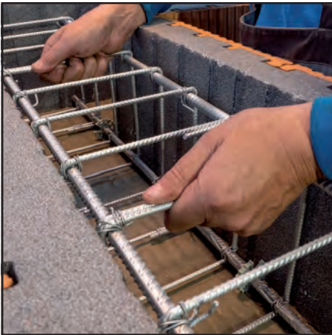
Die statische Bewehrung wird in den Hohlraum zwischen den Dämmelementen eingelegt.
