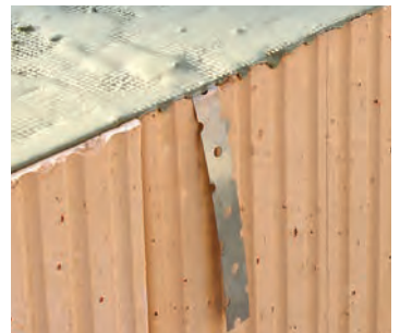
Der Maueranker wird beim Aufrollen des Mörtels perfekt eingebunden. Beim späteren Mauern der Zwischenwand werden diese hochgebogen und in die Lagerfuge der anzuschließenden Wand eingebunden.
