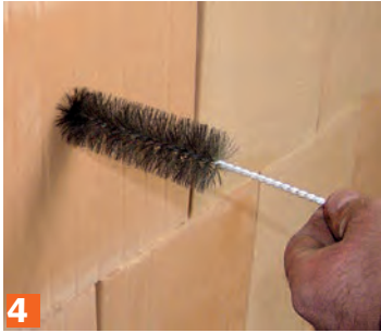
4 Bohrlöcher durch Ausblasen, Aussaugen oder mit Bürste reinigen (Bohrmehl beeinträchtigt die Haftung), erst dann Dübel setzen.
