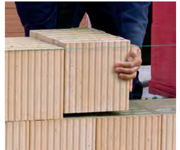
Aufsetzen der Steine und Ausrichten. Fertig!
