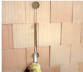
Vorgesägte Schlitzte mit Hammer und Meißel freischlagen.
