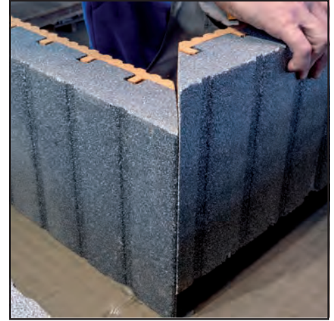
Für Eckverbindungen wird mit der Ziegel- oder Bandsäge ein Gehrungsschnitt erstellt.
