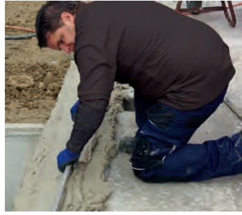
schicht aus Zementmörtel M10 mit wärmedämmenden Eigenschaften (Kimmerschicht-Mörtel maxit therm 825) mit Anlegefix und Alulatte maßgenau angelegt und abgezogen.
