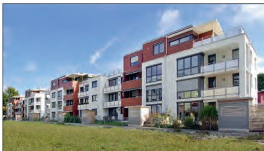
34) Wohnanlage (mit MZ10 gebaut)
