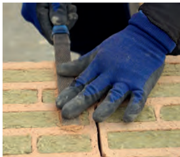
Mit der Steinraspel wird eine kleine Vertiefung in die Außenwand eingefügt, in die später der Maueranker eingelegt wird.
