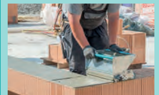
Mörtelrollen von 175 - 490 für den einfachen und sauberen Kleberauftrag
