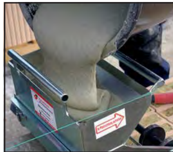
Der angerührte Dünnbettmörtel wird in die Mörtelrolle gefüllt. Zuvor sollte das Gerät mit einem Trennmittel eingesprüht werden, das erleichtert die spätere Reinigung.
