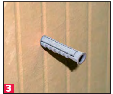
3 Bohrlochtiefe etwa 10 mm größer als Dübellänge, damit die Schraube über die Dübelspitze herausragen kann.
