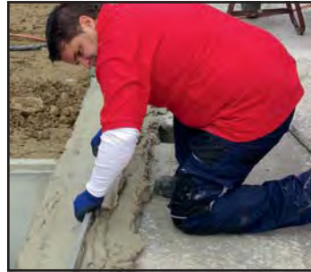
gleichsschicht aus Zementmörtel M10 mit wärmedämmenden Eigenschaften (Kimmerschicht-Mörtel) mit Anlegetfix und Alulatte maßgenau angelegt und abgezogen.
