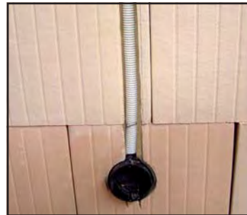
Einlegen der Elektroinstallation in die Schlitzte.
