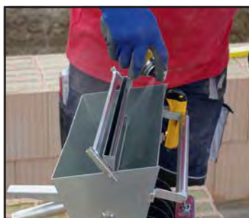
Erstes Anfahren: Gerät mit Trennmittel oder Schalöl einsprühen (das erleichtert die spätere Reinigung der Walze). Glasvliesrolle aufsetzen und Vlies mittig im Führungskanal des Vorratsbehälters einführen.
