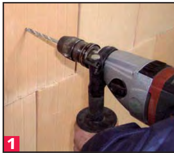
1 Bohrlochherstellung im Drehgang. Bei Ziegeln wird damit das Bohrloch nicht zu groß bzw. die Stege im Ziegel brechen nicht aus.
