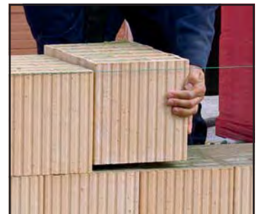
Aufsetzen der Steine und Ausrichten. Fertig!
