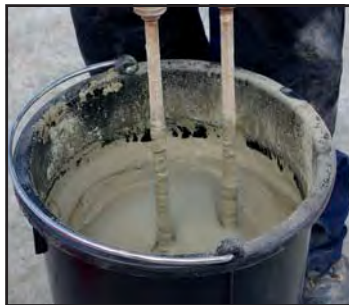
Mörtel in sauberem Eimer mit Doppelrührquirl (z.B. Collomix DLX 152 HF) klumpenfrei anrühren. Mischzeit: 3 Minuten. Mörtel reifen lassen und nochmals durchrühren.
