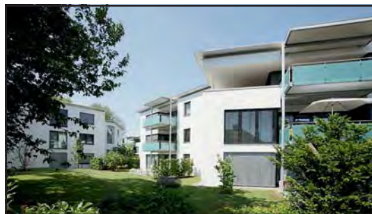
28) Wohnanlage (mit MZ8 gebaut)
