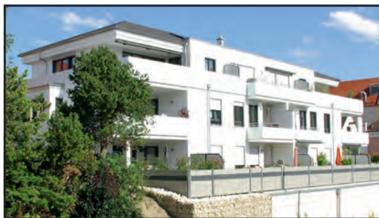
38) Wohnanlage (mit MZ10 gebaut)
