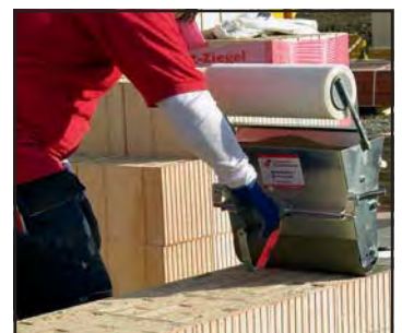
Öffnungsgriff betätigen und starten. Die V.Plus®-Walze wird in Schrittgeschwindigkeit über die untere Ziegellage gezogen (den Behälter während der Verarbeitung nie völlig entleeren).
