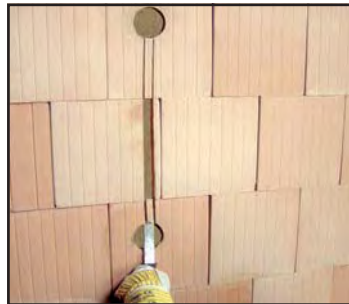
Vorgesägte Schlitzte mit Hammer und Meißel freischlagen.
