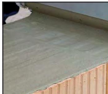
Die Mörtelwalze deckelt in einem Arbeitsgang die Lagerfuge vollflächig mit Dünnbettmörtel.
