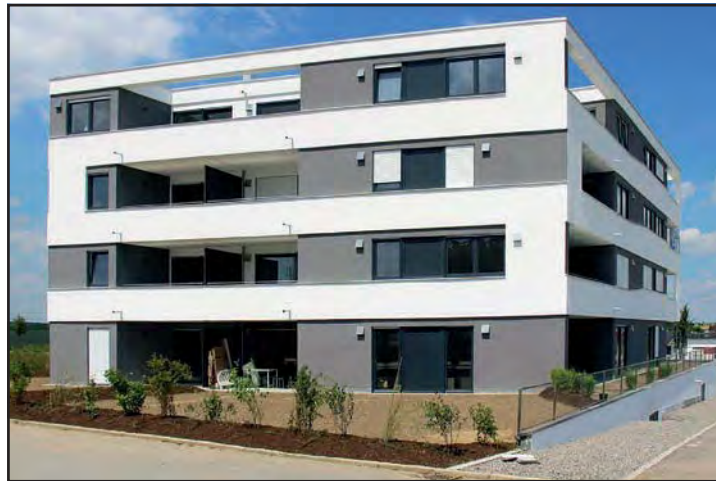
Das neu gebaute Mehrfamilienhaus aus ThermoPlan MZ10 in Langenau. Erst auf den zweiten Blick erkennt man die Abdeckhauben der Lüftungsgeräte.
