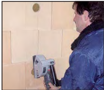
Schlitzten der Ziegel mit der Schlitzfräse.
