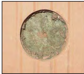
Evtl. Ziegelreste und Bohrmehl entfernen – fertig ist ein perfektes Loch für eine Elektrodose!
