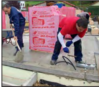
Auf der Betondecke wird zunächst eine Bitumenpappe R500 ausgelegt, Stöße 20 cm überlappend. Um Unebenheiten im Untergrund auszugleichen, wird eine Aus-
