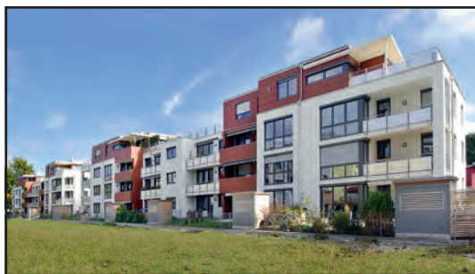
40) Wohnanlage (mit MZ10 gebaut)
